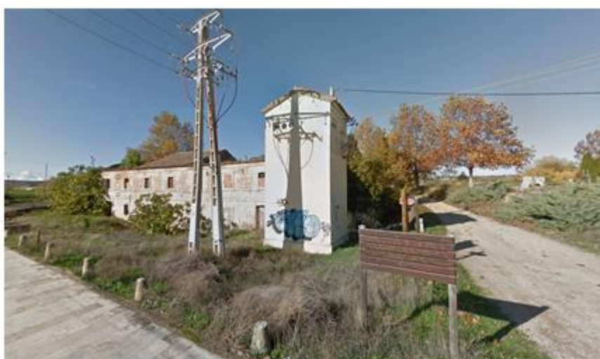
Fábrica de harinas-central hidroeléctrica de Palencia
