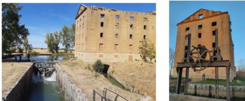
Antigua fábrica de harinas en Tamariz de Campos (Valladolid)
